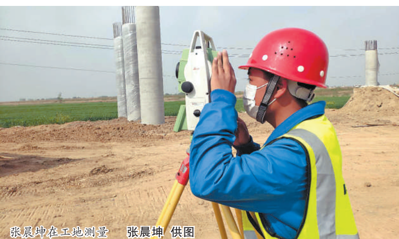
张晨坤在工地测量 张晨坤 供图
